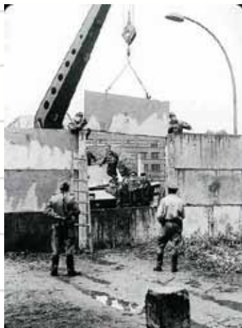
Costruzione del muro.
